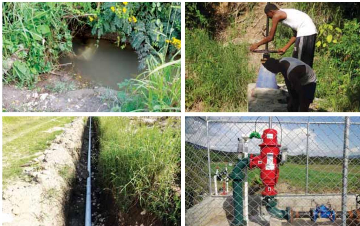
Foto 8. Contrastes en la operación y eficiencia en la conducción de agua entre los sistemas de riego mediante canales de tierra (parte superior) y riego por conducto cerrado (parte inferior).
